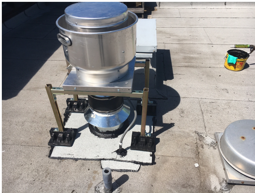
Central mitigation fan
